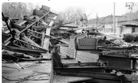
7. ábra: A lebontott vasszerkezet a Várad-olaszi oldalon, 1981. Darabont József gyűjteményéből
