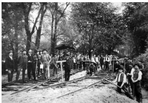
Pályaátépítés a Margitszigeten
