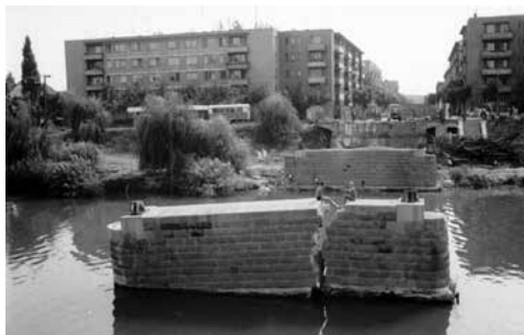
8. ábra: Rálátás a megrepedt hídlábra. Rajta merész fürdőzők, 1981. Darabont József gyűjteményéből
